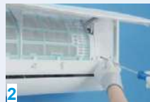
2 Îndepărtați UN șurub din cutia de comandă electronică
